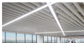
Gérer et optimiser l'éclairage
