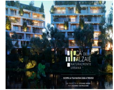
Cazzaro Costruzioni Treviso 60 connected apartments
